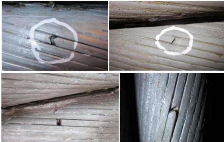
Vermoeiingen en scheurtjes in de tuien
